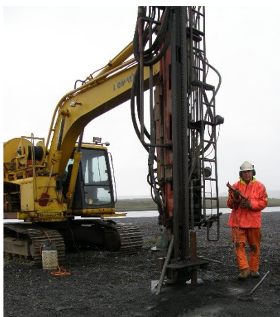
Mynd 6-29 Bormenn Ræktó við Odexborun í brúarstæði við Hvítá. Fódurrörin eru soðin saman og skilin eftir, hægt er að safna salla úr skolvatninu til nánari skoðunar og mats á bergi.
