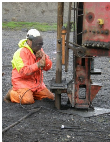
Mynd 6-29 Bormenn Ræktó við Odexborun í brúarstæði við Hvítá. Fódurrörin eru soðin saman og skilin eftir, hægt er að safna salla úr skolvatninu til nánari skoðunar og mats á bergi.
