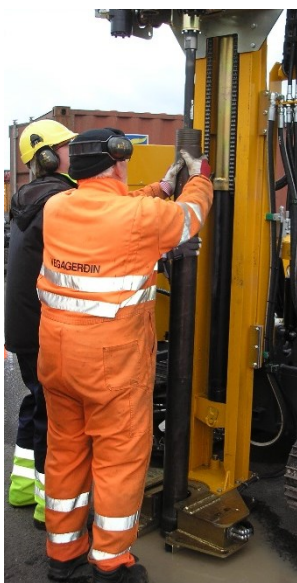
Mynd 6-31 Borhausinn festur á borstöng; fódurrörið stillt af og borhausinn færður niður rörið og læst í ytri krónuna. Fódurrörið borað niður með vatnsskolun.
